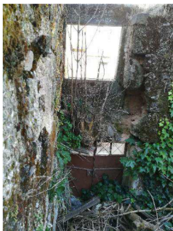
Foto n.º 14 – face interior dos vãos identificados na foto 10 e 13)
