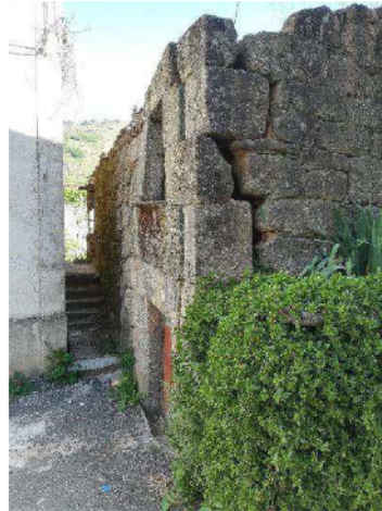
Foto n.º 2 – fachada principal
