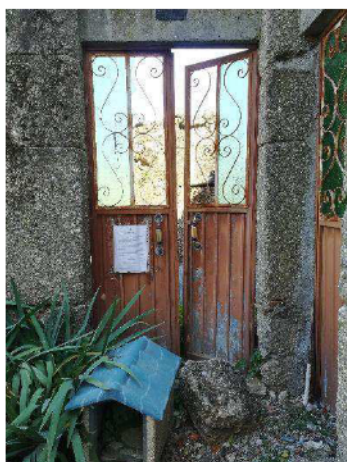
Foto n.º 11 – vão de soleira
