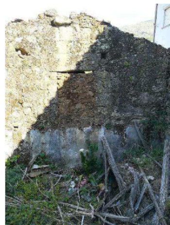
Foto n.º 15 – vão de soleira interior, encerrado e de comunicação interior com outro prédio urbano a nível do piso 1
