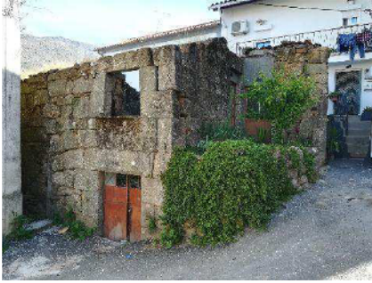
Foto n.º 1 – fachada principal
