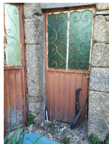
Foto n.º 12 – vão de soleira
