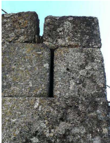
Foto n.º 4 – fissuramento das fachadas (alçado principal)
