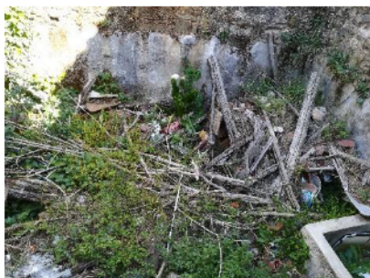
Foto n.º 19 - interior
