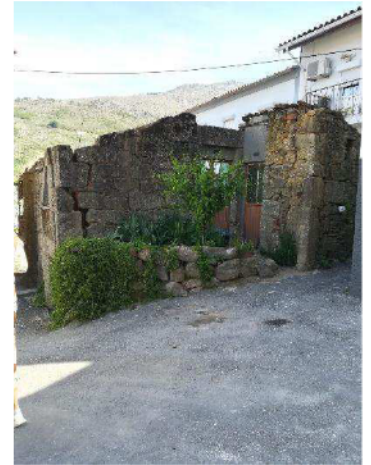
Foto n.º 3 – fachada lateral direita
