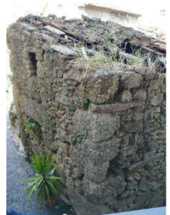
Foto n.º 9 – fachada lateral direita e posterior e cobertura
